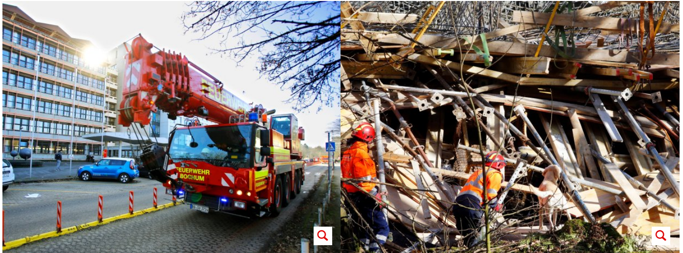
Ein Kran der Feuerwehr verlässt die Lennershofstraße. Mit dem schweren Fahrzeug konnten die Einsatzkräfte nicht bis zur Unfallstelle vorfahren. Stattdessen nutzten sie einen Baukran für die Bergung der Verletzten. Einsatzkräfte und ein Spürhund untersuchen die Trümmer der Baustelle. Foto: Dietmar Wäsche
